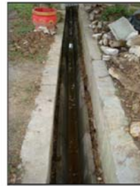
Kerja membaikpulih longkang Taman Murni
