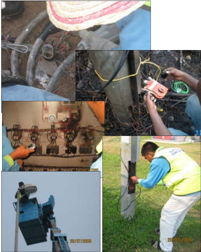
Kerja menyelenggara lampu jalan
